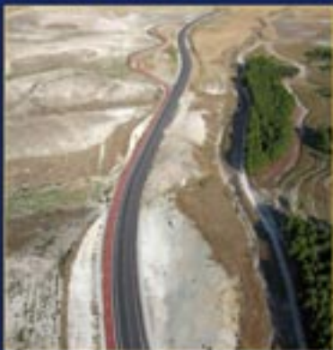
Carreteras e Infraestructuras en general.
